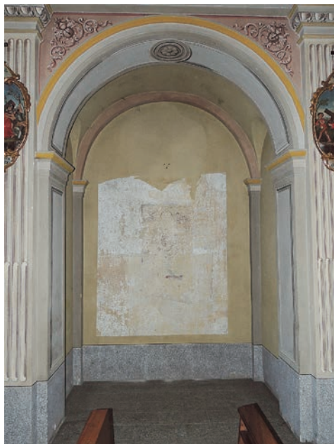
Prima del restauro
