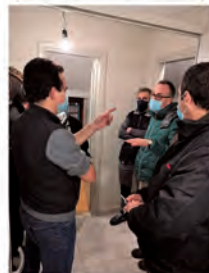
... si chiude con una riunione di cantiere improvvisata!
