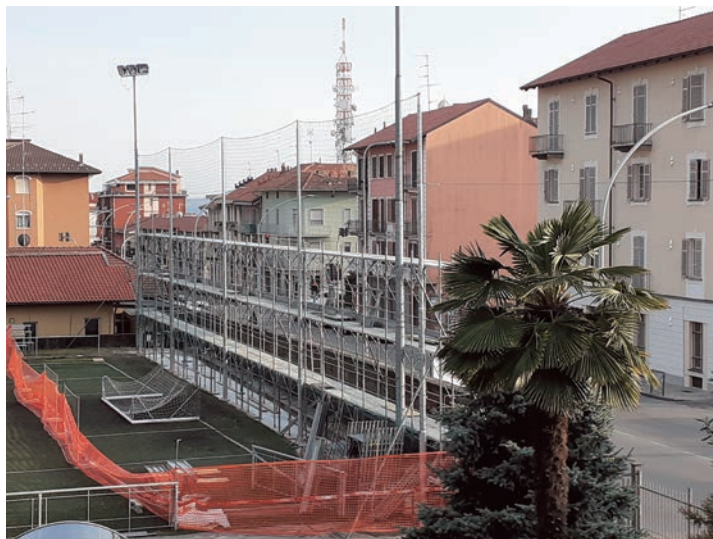
Il ponteggio per issare i nuovi pali e montare la nuova rete di protezione
